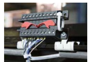
Rys. 9.b. Listwa zaciskowa rozłączana
