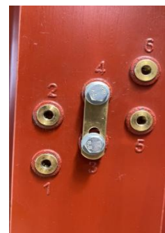
Rys. 1. Przełącznik zaczepów – przykład: regulacja 5 pozycyjna.
