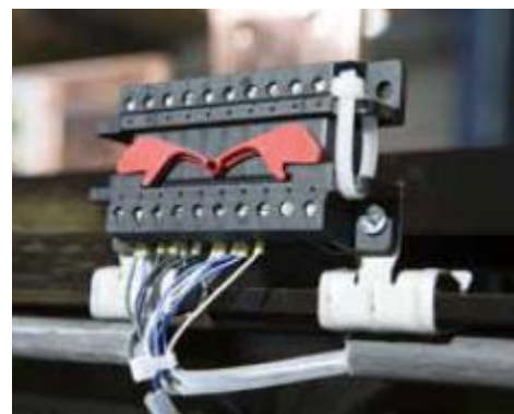
Rys. 9. Listwa zaciskowa
