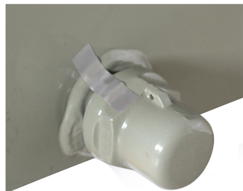
Rys. 12. Zawór spustu oleju
