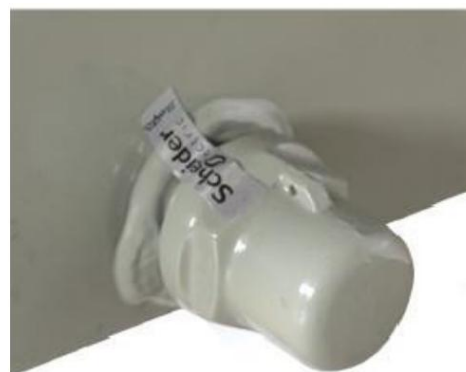
Obr. 12: Vypouštěcí ventil
